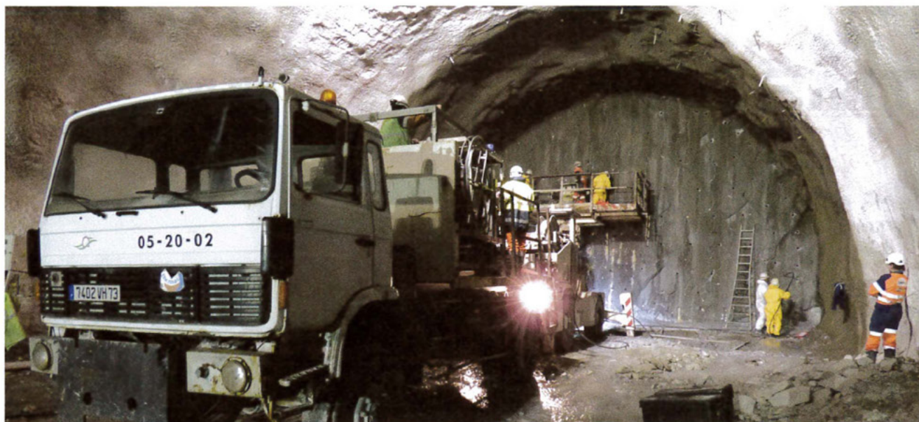
Le système M.O.R.S.E® d'EPC France en action au front de taille de la galerie de reconnaissance de Saint-Martin-la-Porte.
