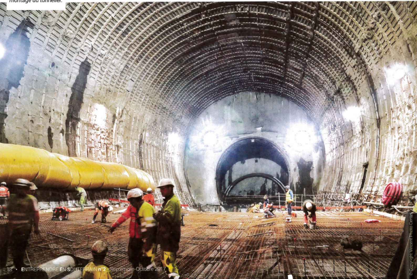
Ferrailage du radier de la chambre de montage du tunnelier.
