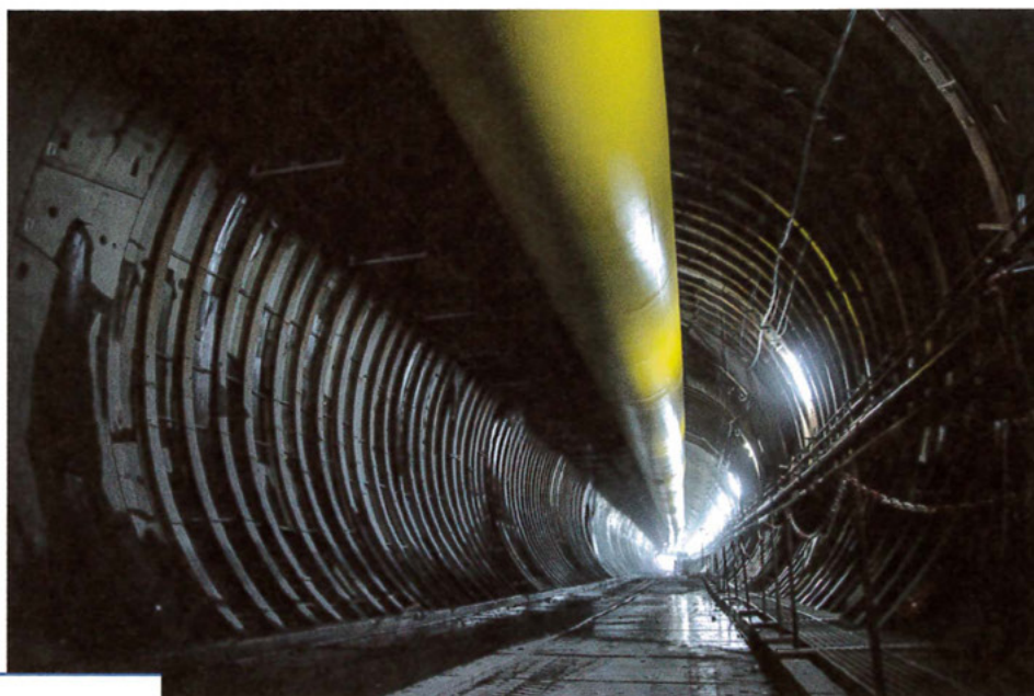
Cintres métalliques HEB à l'intérieur des anneaux de voussoirs.
