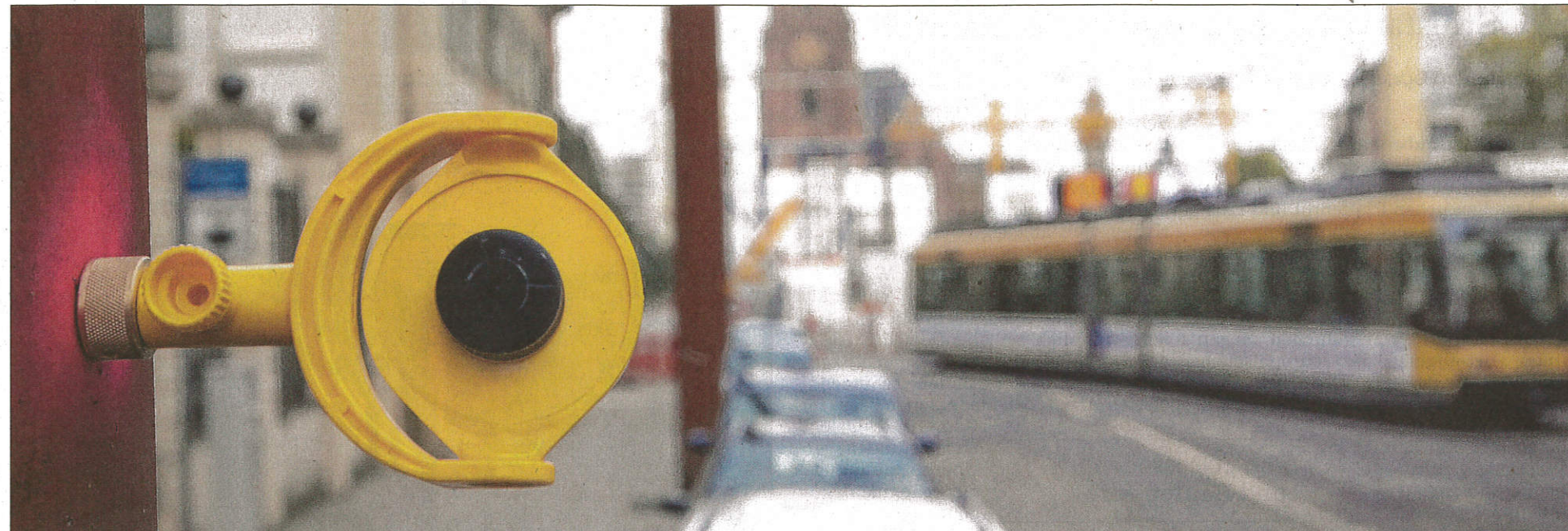
DREIDIMENSIONALE DAUERMESSUNG: Die Gebäude im ersten Bohrabschnitt auf der Kaiserstraße wurden mit diesen gelben Plastikhalterungen ausgestattet, in denen sich spezielle Spiegel befinden. Stündlich wird mit diesem Verfahren dokumentiert, ob sich die Häuser über dem Tunnelbohrer auch nur minimal bewegen. Fotos: jodo (2)/dpa
