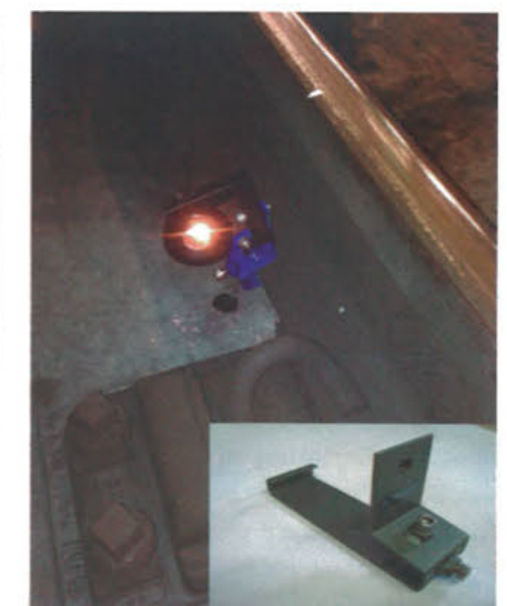
Bild 3a (oben): Installation von mehr als 70 Prismen an den Gleisen der Wynyard-Station zur Überwachung der Sollgeometrie, Spurweite und Überhöhung
