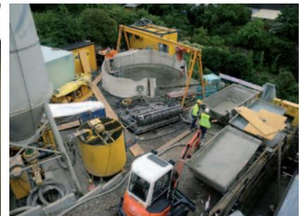
Bild 10: Schacht für die Hebungsinjektionen (Foto: Sterzik)
