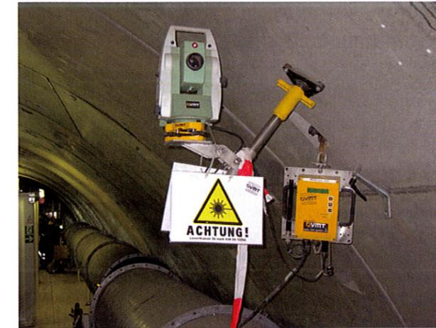
Bild 4: Steuerungstachymeter mit Datenbox und WLAN-Übertragung (Foto: Knoll)
