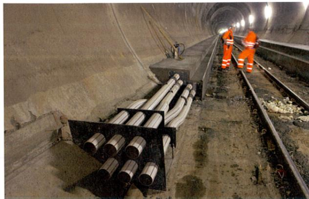
Abb. 8: Bau des Banketts.
