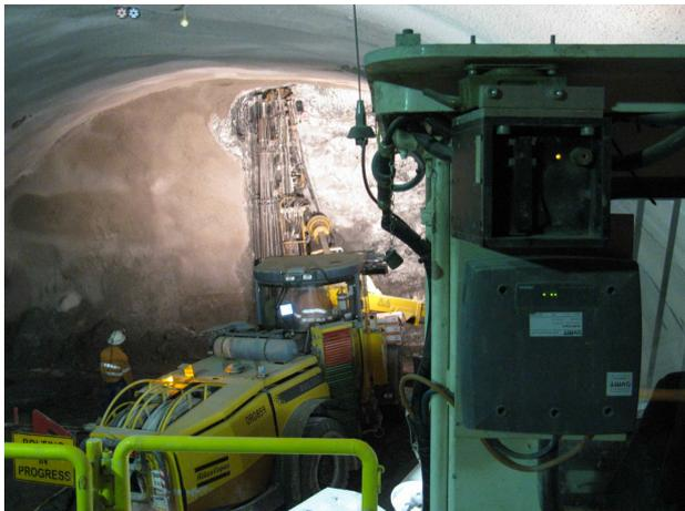
Zeigten doch bereits die Erfahrungen, die mit diesem System bei einem kleineren Projekt in Melbourne gesammelt wurden, dass sich der Spritzbetonbedarf um rund 20% reduziert und der Zeitbedarf für den Spritzvorgang entsprechend kürzer ausfällt.
