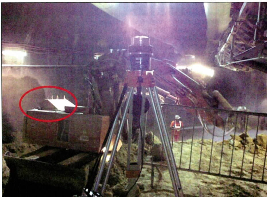
6 iGPS Test im Tunnel, die Sensoren auf dem Bagger sind rot umkreist
